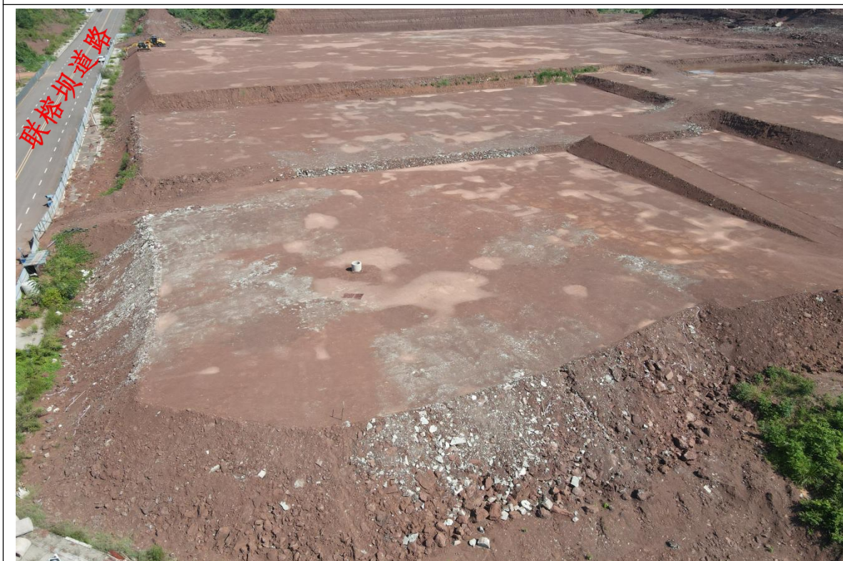
图 2 本项目周边情况（北侧--联榕坝道路）
